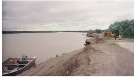
Yukon Rv Shoreline Erosion 1.JPG
